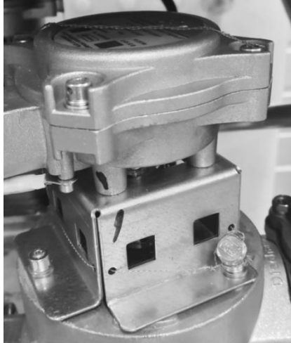
Рисунок В.1 Пломбировка генератора импульсов
