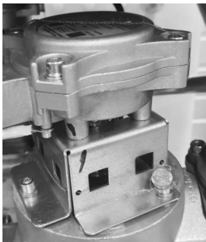
Рисунок В.1 Пломбировка генератора импульсов
